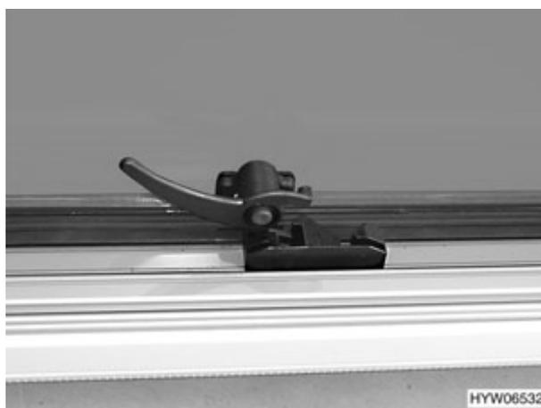
Fig. 40 Fenêtre projetante sur la position "Aération permanente" (variante 2)
