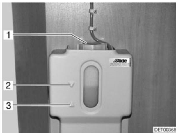
Fig. 188 Vase d'expansion pour le chauffage à eau chaude
