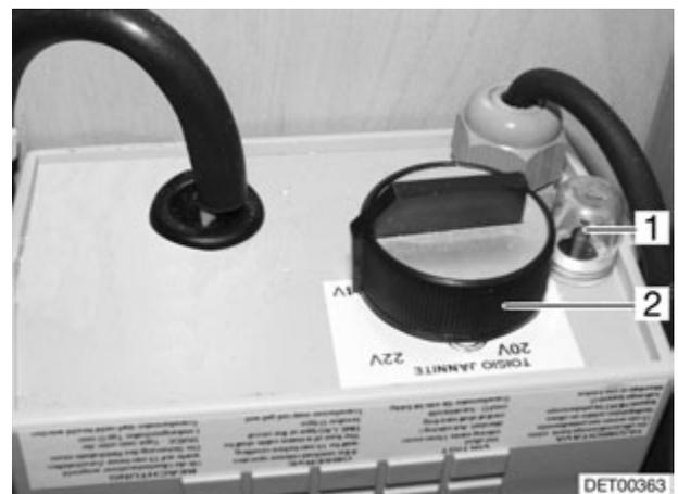
Fig. 133 Régulateur du chauffage électrique du plancher
