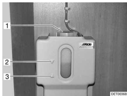
Fig. 160 Vase d'expansion pour le chauffage à eau chaude
