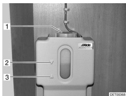
Fig. 223 Vase d'expansion pour le chauffage à eau chaude
