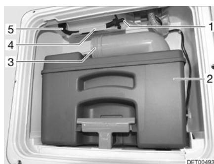
Fig. 221 Tuyau d'écoulement réservoir d'eau toilettes
