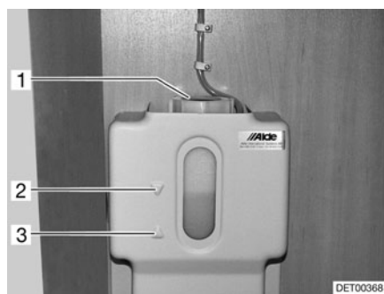
Fig. 178 Vase d'expansion pour le chauffage à eau chaude
