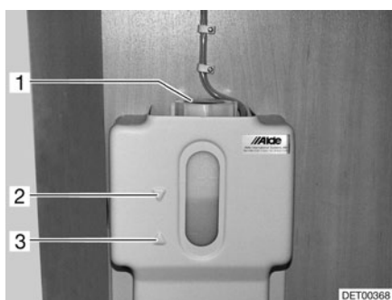
Fig. 243 Vase d'expansion pour le chauffage à eau chaude
