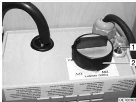
Fig. 129 Régulateur du chauffage électrique du plancher
