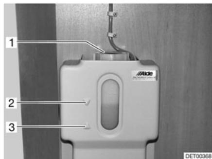
Fig. 181 Vase d'expansion pour le chauffage à eau chaude
