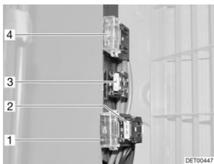
Fig. 168 Fusibles de la batterie de cellule (Fiat)
